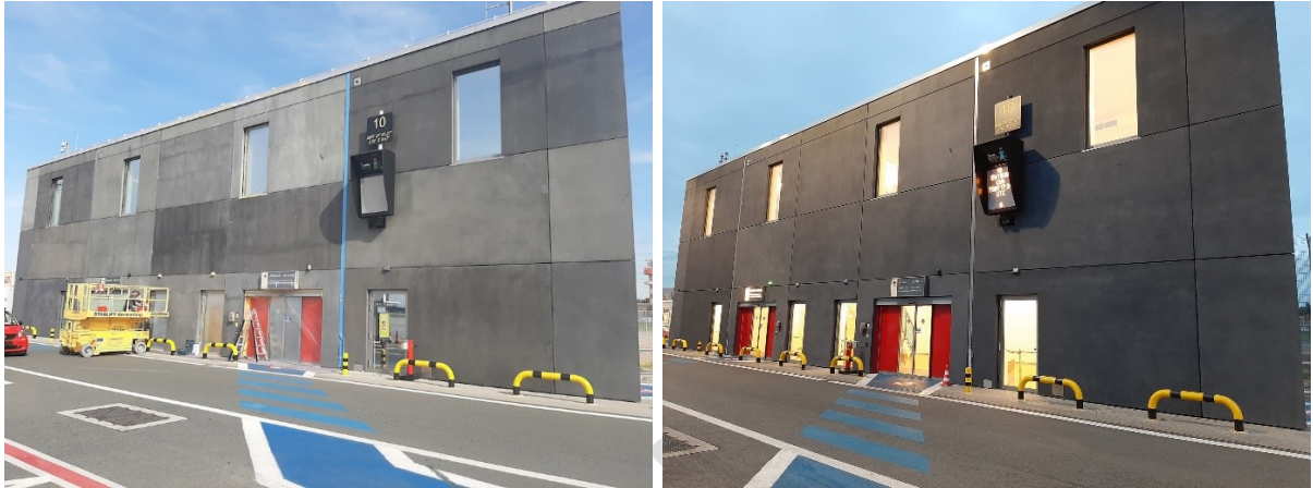
Abbildung 5.16: Beispiel für die Farbtonangleichung durch eine Lasur (links vor, rechts nach Lasurauftrag)
