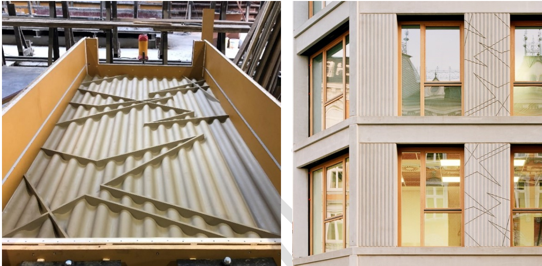
Abbildung 5.9: Einsatz von Matrizen (links: Schalung mit eingelegter Matrice, rechts: fertig montierte Bauteile in der Fassade)
