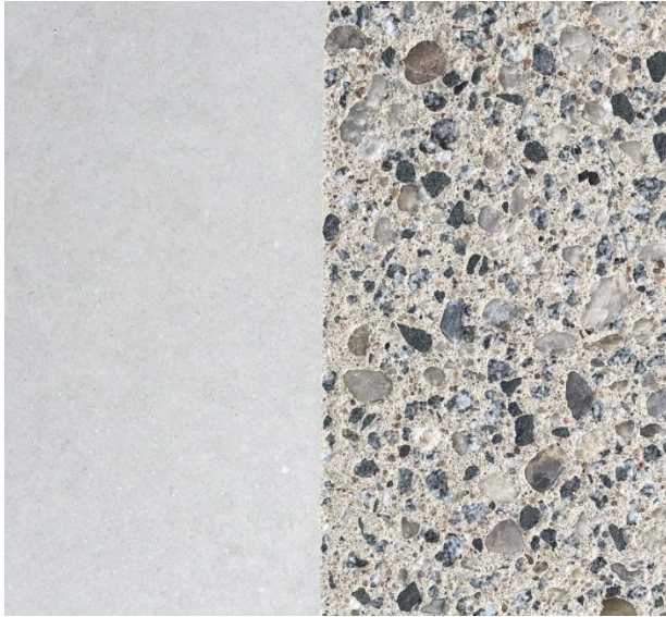
Abbildung 5.13: Beispiel für schalungsglatte (links) und stark gestrahlte (rechts) Sichtbetonoberfläche
