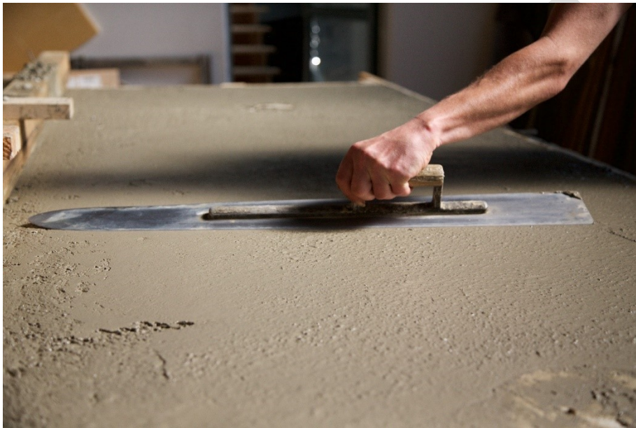
Abbildung 4.1: Händisches Glätten einer ungeschalteten Einfüllseite
