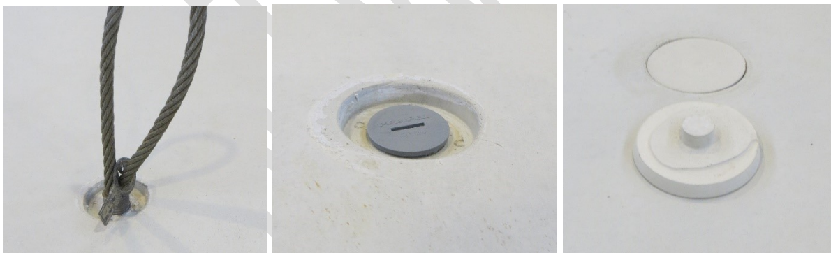
Abbildung 5.6: Transportanker – mit eingeschraubter Seilschleife (links) – mit Verschlussstopfen aus Kunststoff (mitte) – mit Verschlussstopfen aus Zementmörtel (rechts)
