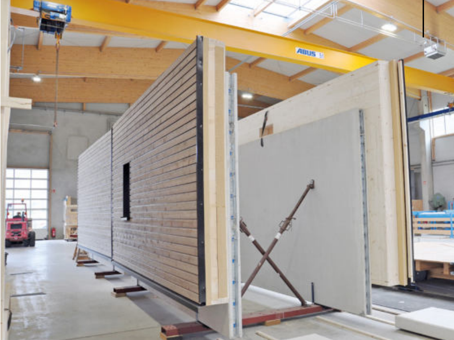
Werkseitige Herstellung der Hybridwand in Holz-Beton-Verbund.
