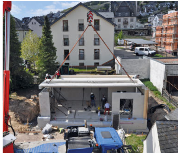
Montage der weitgespannten Deckenplatte für eine Moduleinheit.
